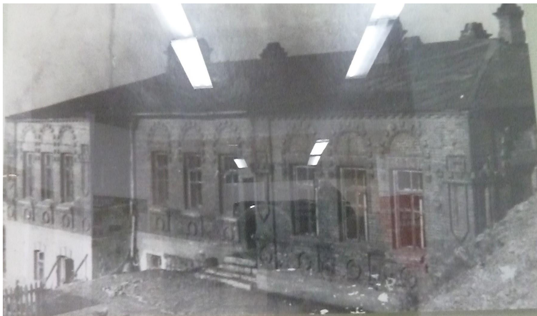
Здание прогимназии М.В.Сибирцевой на ул.Комарова, г.Владивосток
